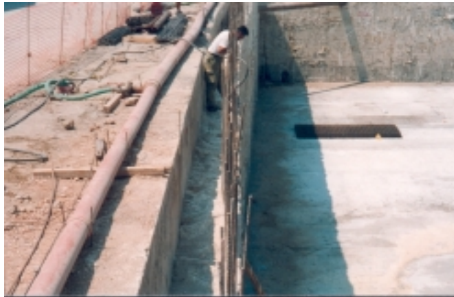
Σχήμα 3-11: Εισπίεση αέρα στον αποκλισιομετρικό σωλήνα
