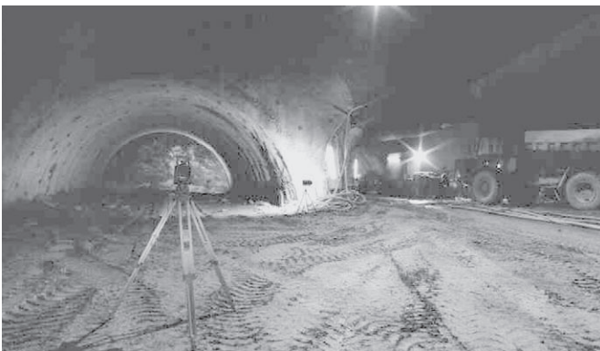
Vortriebssteuerung · Digitale Hohlräumersfassung Geotechnische Messung und Dokumentation
