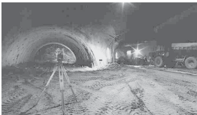
Vortriebssteuerung · Digitale Hohlräumersfassung Geotechnische Messung und Dokumentation
